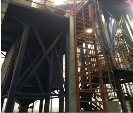
喷塑废气旋风+滤袋
