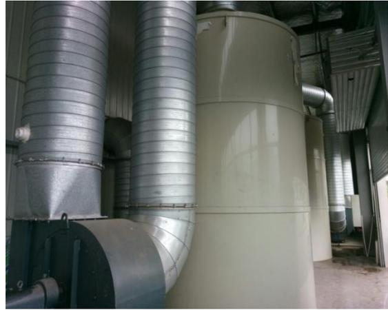
喷塑废气喷淋塔
